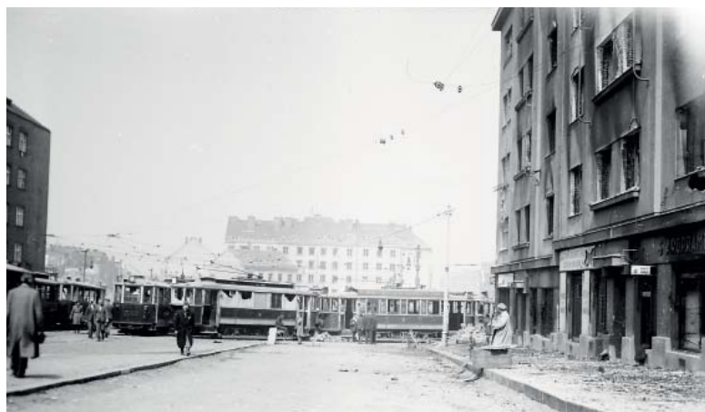
Barikáda z tramvají v ulici 5. května. Foto: archiv MČ Praha 4
