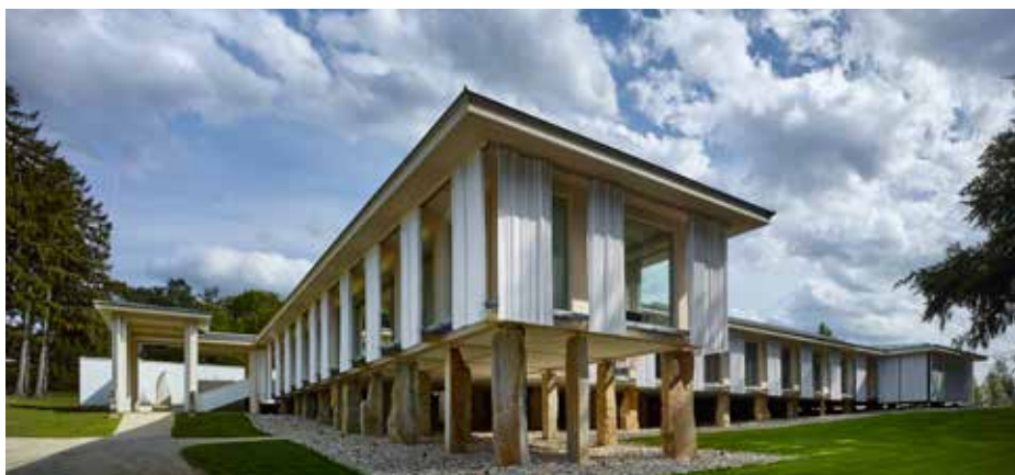
Ājurvédský pavilon, stojící na více než stovce žulových monolitů, byl v loňském roce oceněn titulem Stavba roku. Foto: archiv JT
