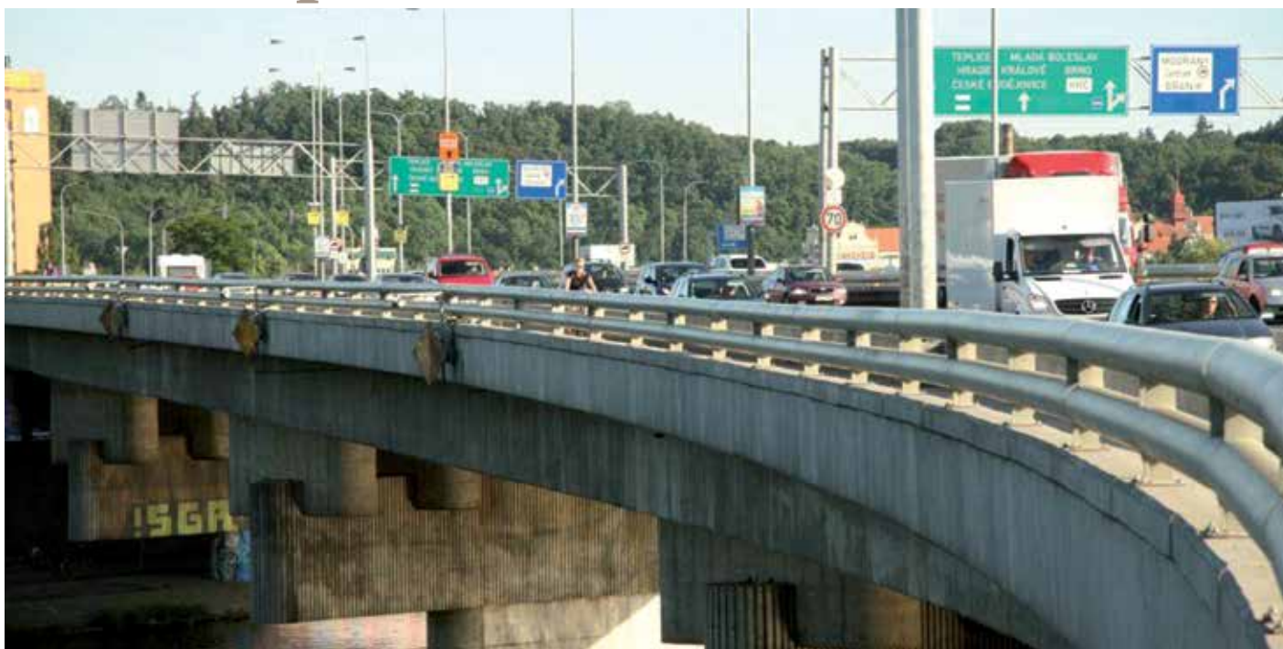
Oprava spojnice mezi dvěma pražskými břehy potrvá několik let a přinese dopravní komplikace. Ilustrační foto: TSK Praha
