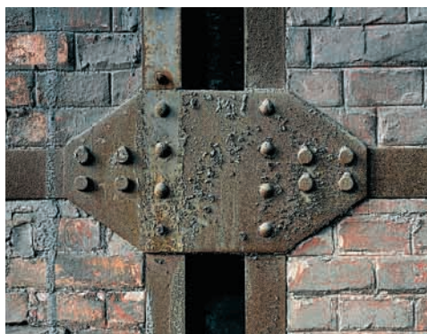
Na stavbě Podolské vodárny se spojují dekorativní a technické prvky.
