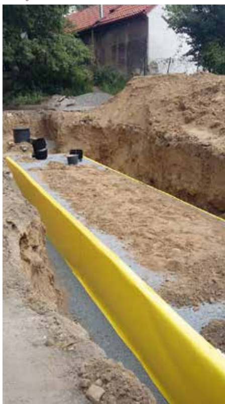
Podzemní vsakovací galerie v ZŠ Školní
