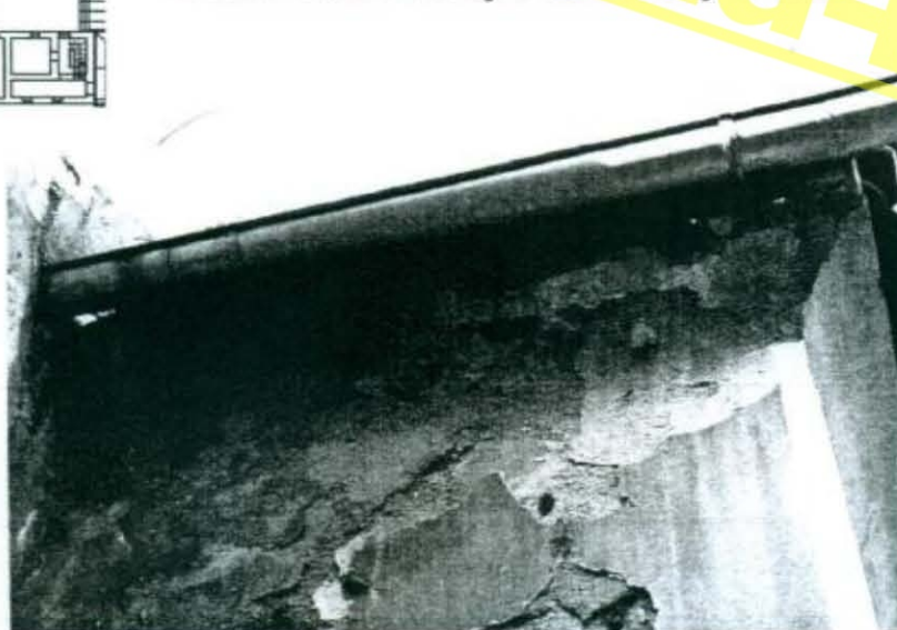
4 Konstrukce římsy z osekávaných cihel
