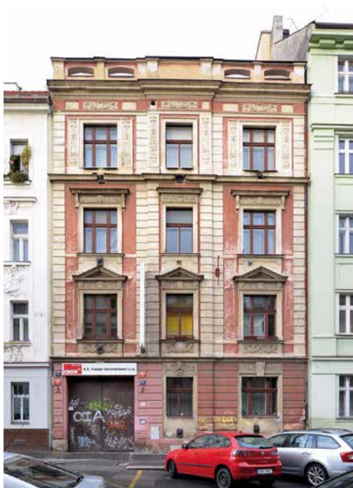
Tuto fasádu domu v Čestmírově ulici oprava teprve čeká.
