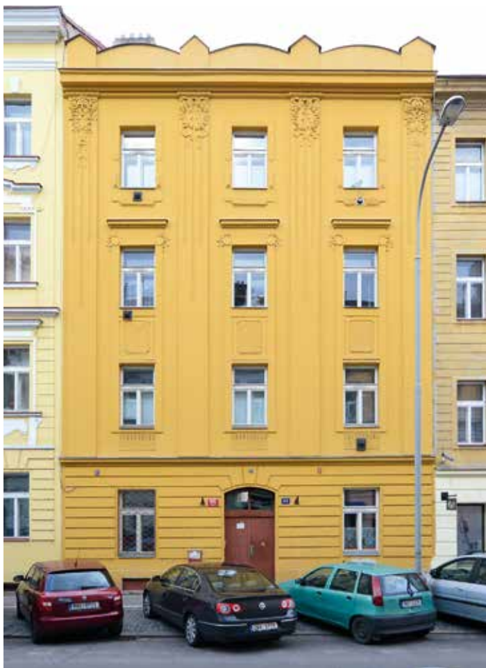
Opravená fasáda domu ve Svatoslavově ulici.
