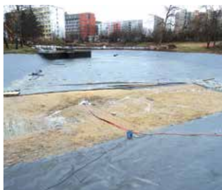
Pokládání fólie na dno prostřední (čisticí) nádrže.
