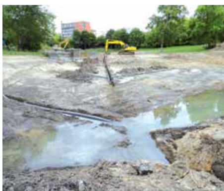
Meliorace pod nádržemi má zabránit tomu, aby hladina spodní vody zvedala ode dna fólii.
