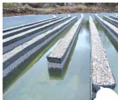
Meandry biotopu z gabionových stěn v horní nádrži ještě před osázením rostlinami.
