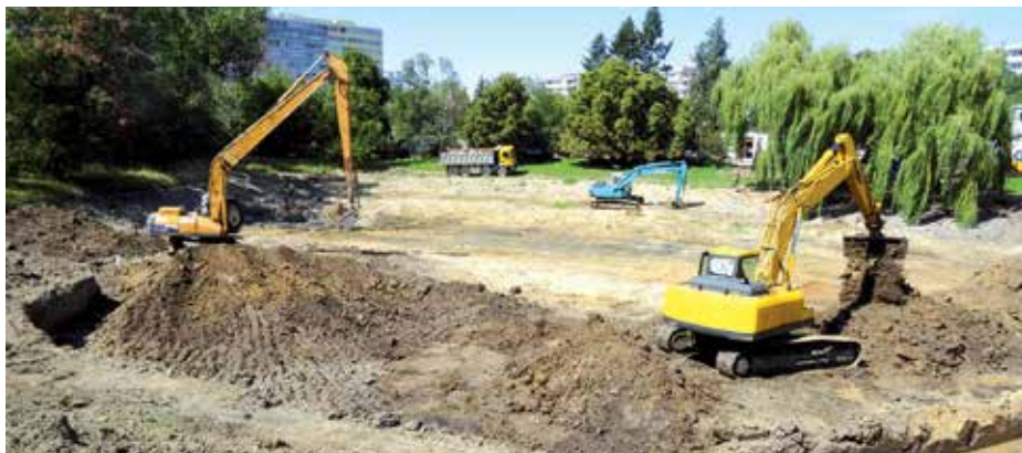
Po demolici starých a nevyhovujících objektů vjely do areálu koupaliště bagry, aby vyhloubily tři nádrže biotopového koupaliště.
