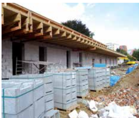
Výstavba hlavního objektu koupaliště se šatnami pro muže a ženy.
