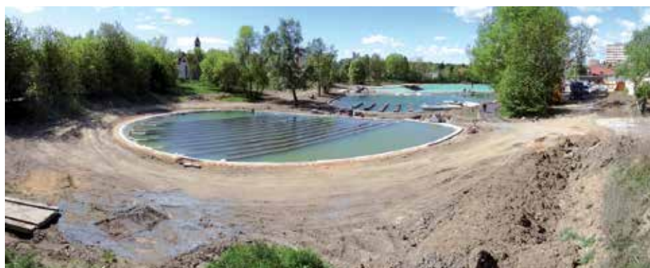
Celkový pohled na rozestavěný areál se třemi nádržemi biotopu.
