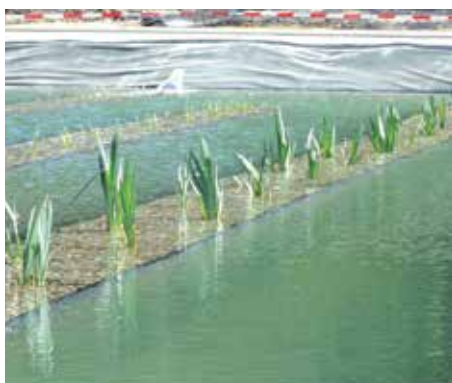
Po osázení rostlinami, které budou čistit vodu.
